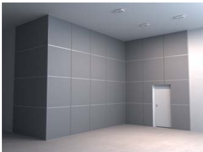
3.11 Montera resterande väggabsorbenter enligt beskrivningen på s. 9 uppifrån och ner. I takt med att absorbernterna monteras täcks alla horisontella skarvar med mellanprofiler genom att klicka i dem i T-fästblecken. När alla absorbernter är på plats återstår bara att täcka de vertikala skarvarna med hela längder av mellanprofiler som klickas i T-fästblecken.
