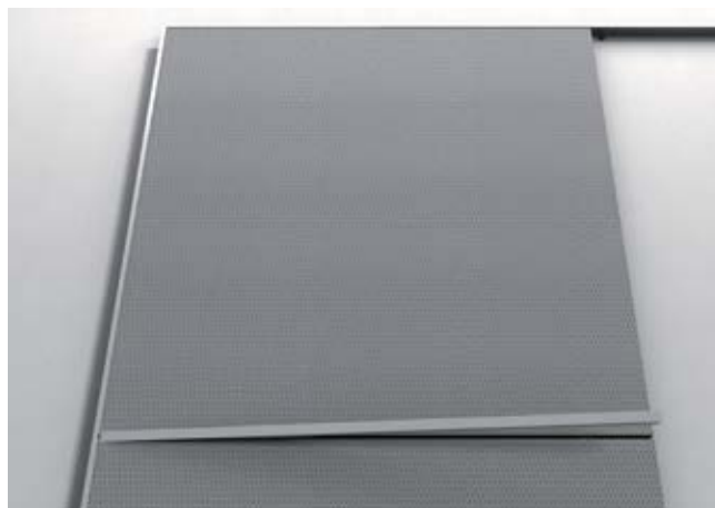
3.6 Täck de horisontella skarvarna genom att klicka i T24 bärprofiler i T-fästblecken. Därefter skjuts profilerna försiktigt under U-profilen. Dessa horisontella mellanprofiler skall klippas i längden M-12 mm.
