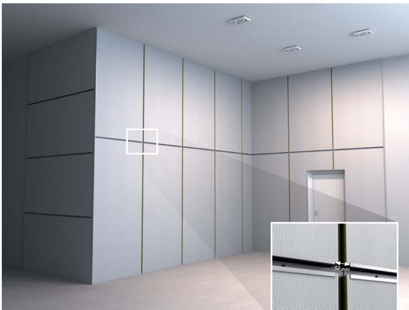
6.4 Montera resten av absorbenterna med horisontella hattprofiler. Arbeta in mot mitten.
